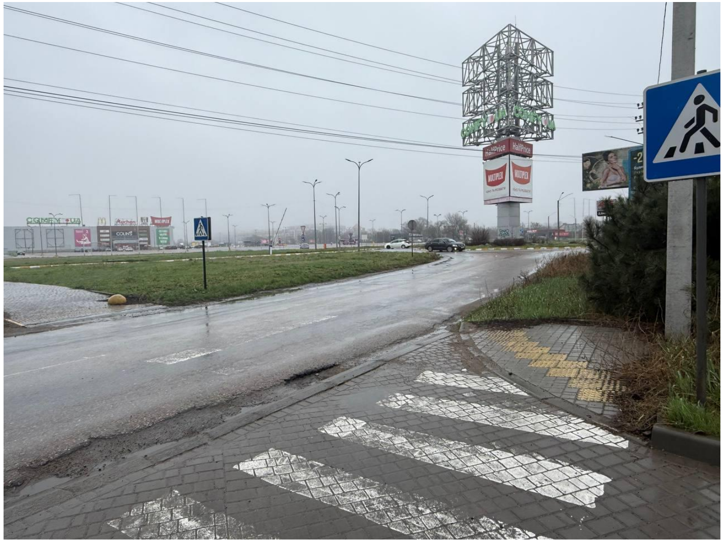
Облаштовано пішохідний перехід у селищі Ліски на розі вулиці Заболотного та вулиці Марсельська.
